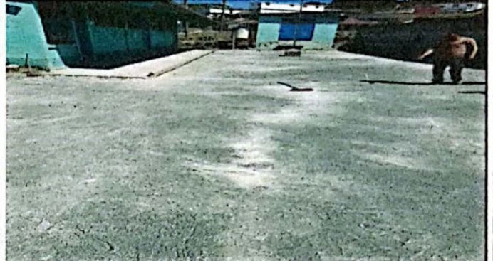
Sustitución de piso de torta de concreto
