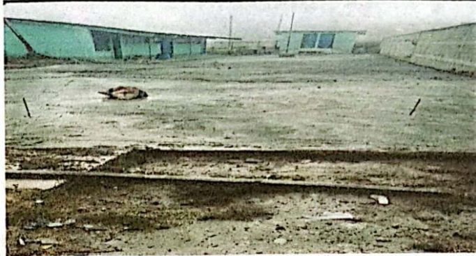
Sustitución de piso de torta de concreto
