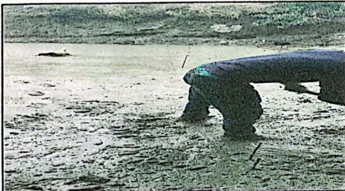
Sustitución de piso de torta de concreto
